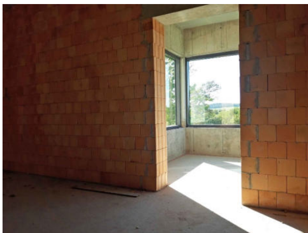
Bild: Der neue Nordflügel der Burg Posterstein ist noch ein Rohbau.
