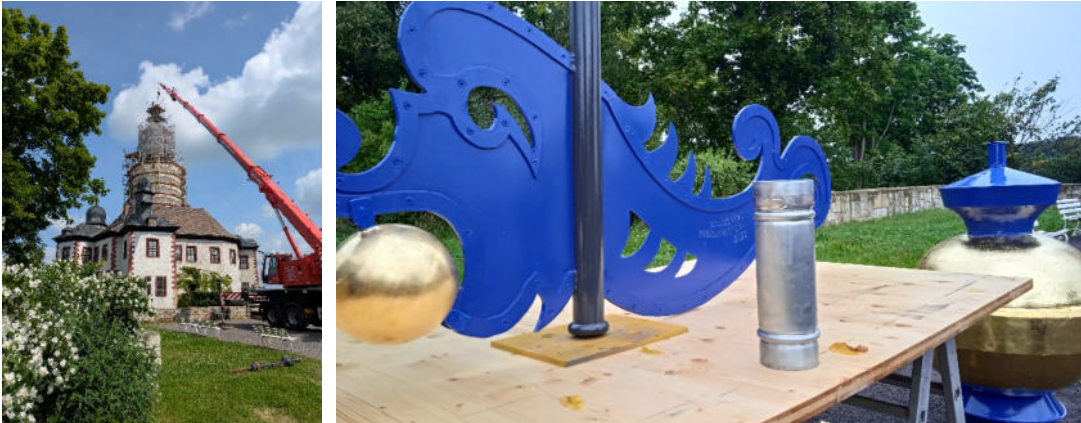
Fotos: Abnahme der Turmkuppel im Juni 2025 und restaurierte Wetterfahne, Kuppel und Zeitkapsel im August 2025.
