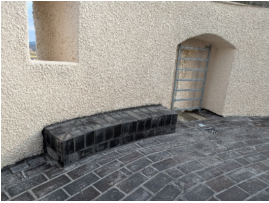
Foto: Sanierte Aussichtsplattform im November 2025
