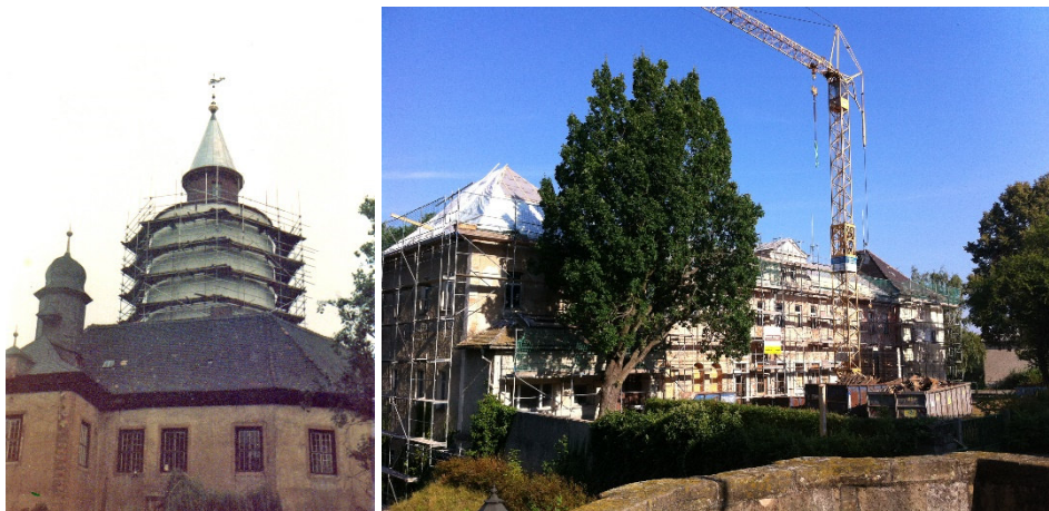
BU: Restaurierung der Burg auf einem Foto von 1984, Restaurierung des Herrenhauses 2016.
