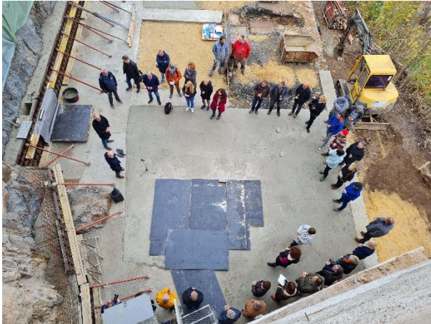
BU: Grundsteinlegung: Blick von oben auf den Bauplatz.
