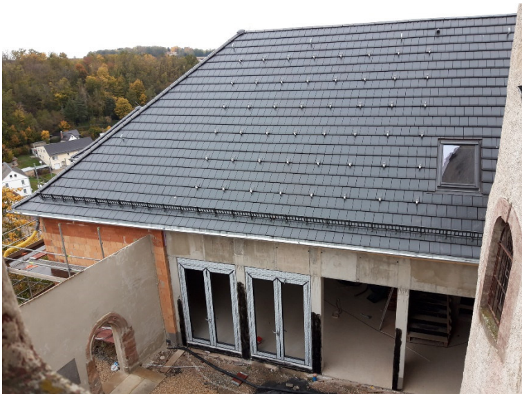
BU: Aktuell werden im Nordflügel-Neubau der Burg Posterstein Fenster eingebaut.
